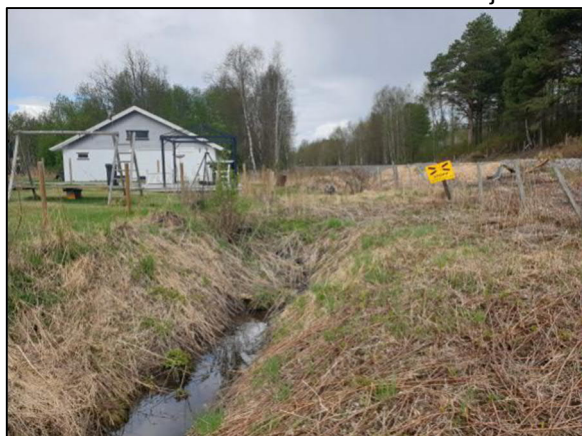
Bilde 1 - sidegrøft (vest) på langs Rørosbanen nord for rv. 3
