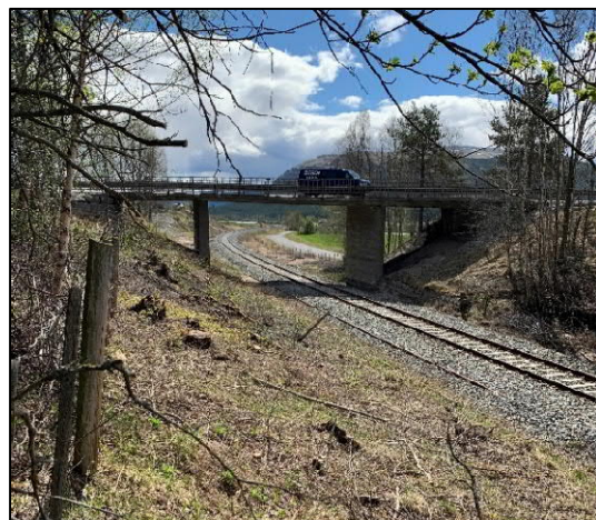
Figur 11: Nesteby bru, med Rørosbanen under (Sweco).
