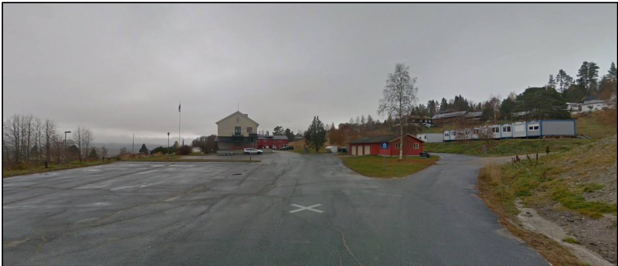
Figur 4.1 Eiendom gbnr. 9/158. Kilde: Google Street View, bilde datert oktober 2019.
