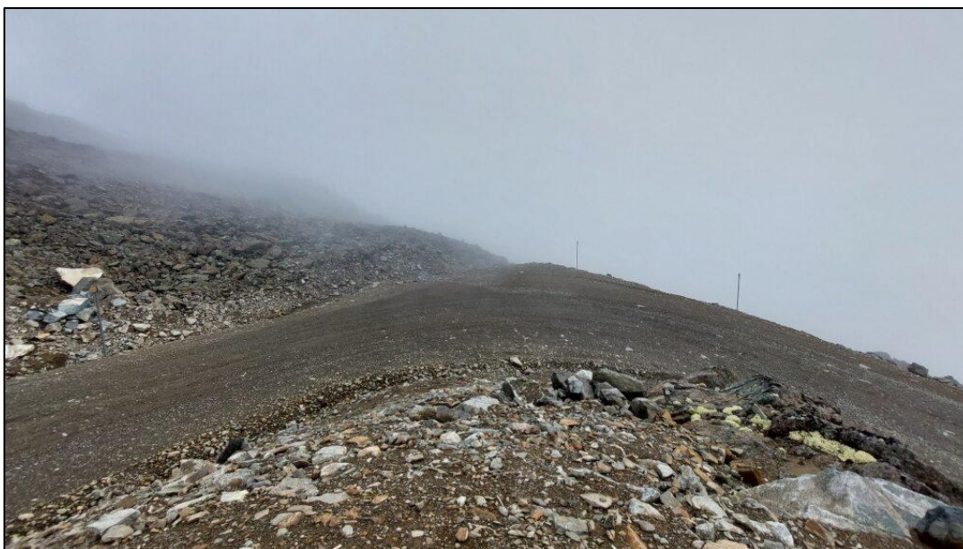
Figur 18: Tronfjellveien i en av de store svingene i øvre del av veien.
