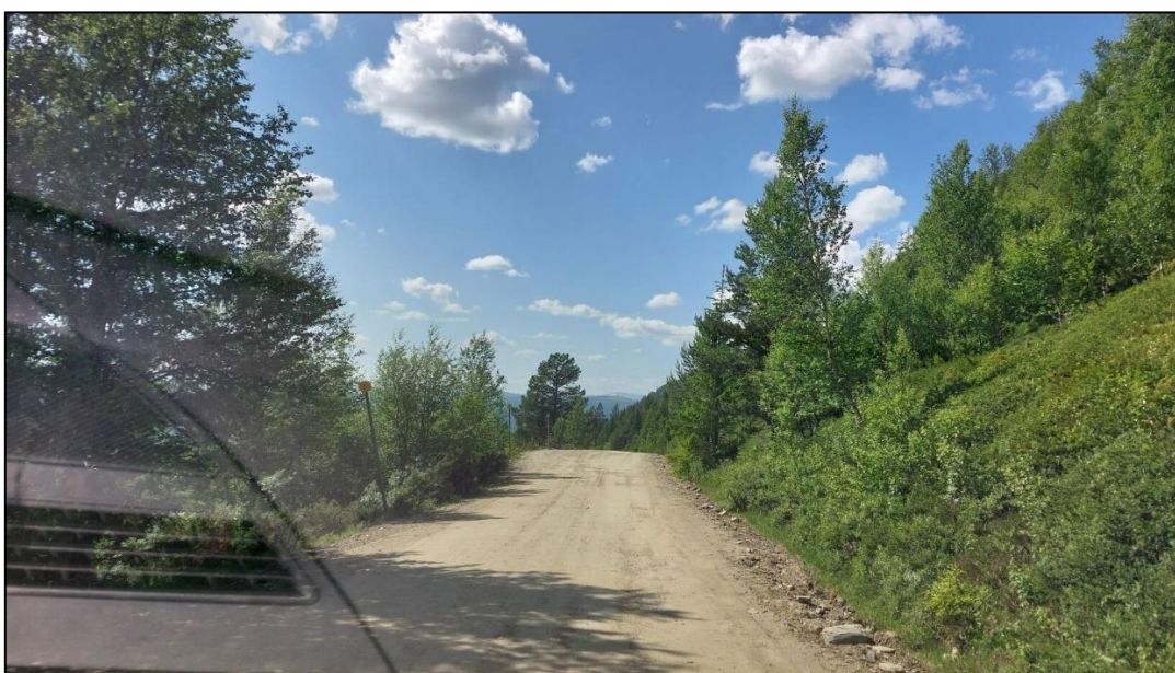
Figur 19: Nærvirkning av veien på delstrekning 1, nedenfor Sørkletten.
