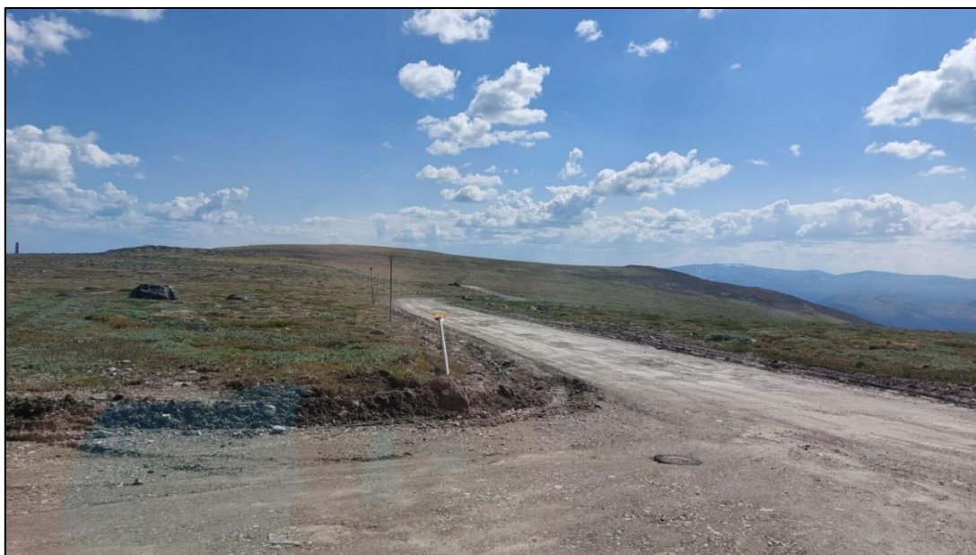
Figur 20: Tronfjellveien i terrenget på Flattron sett fra garasjeanlegg.
