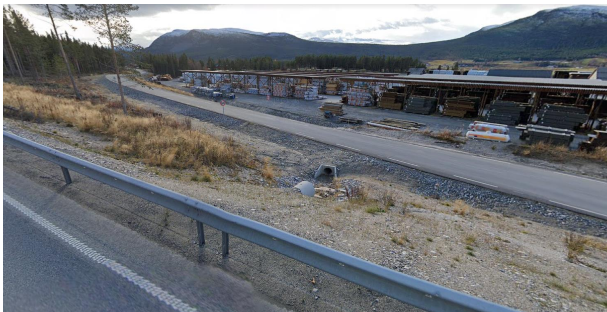
Bilde av gjennomføring av stikkrenne riksveg 3 og Kvebergsveien
