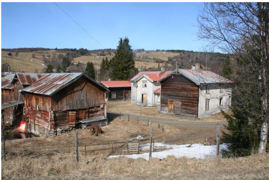
Figur 10. Garden Strømsnes, Brua, Kvikne. Intakt gardstun med tidligere forretning og et bolighus fra 1600-tallet. Foto: Per Hvamstad.
